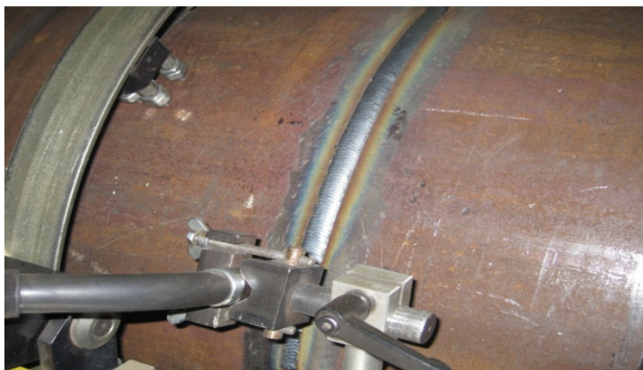
Рис. 7. – Облицовочный валик шва трубы 530х8мм
