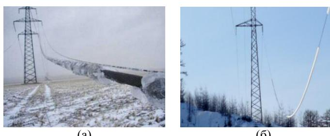
Рисунок 1 – Гололедные отложения: а) ВЛ 220кВ РоАЭС-Волгодонск II цепь, б) ВЛ 110кВ Зимовники-Ремонтное [Glazed blankets: a) VL 220kV RoNPP-Volgodonsk II circuit, b) VL 110kV Zimovniki-Remontnoye]
