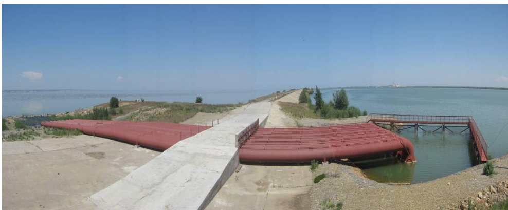
Рис. 1. – Сифонный водосброс водоёма-охладителя Ростовской АЭС
