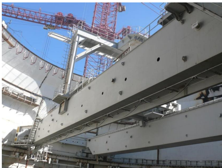
Рис. 4. – Установка крана на рельс
