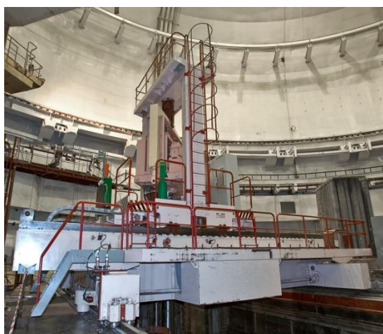
Рис. 1. – Машина перегрузочная МПС-В-1000
