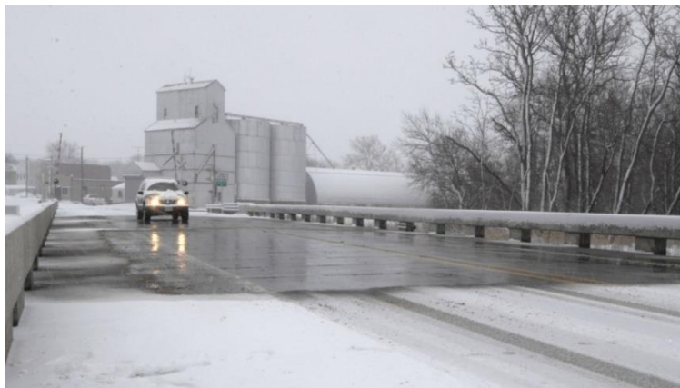
Рисунок 1 – Мост «Roca Spurt»
