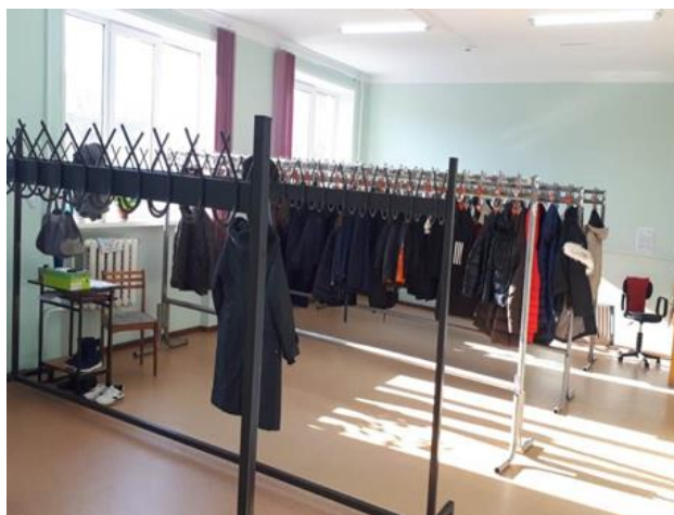
Рисунок 6.1.2. Ремонт гардероба, в корпусе на ул. Ленина, 98
