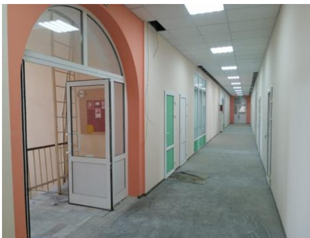
Рисунок 6.1.1. Ремонт помещений в корпусе на ул. Ленина, 27
