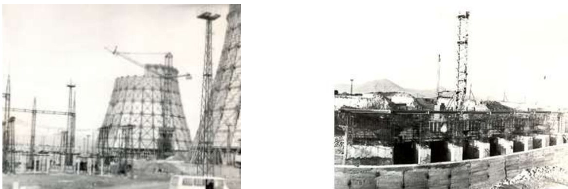
Рисунок 1 – Строительство 1-го блока ААЭС, 1970 г. [Construction of ANPP Unit 1, 1970]
