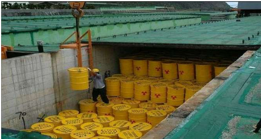
Рисунок 5 – Общий вид ПЗ ОНАО [General view of the very low level waste disposal facility]
